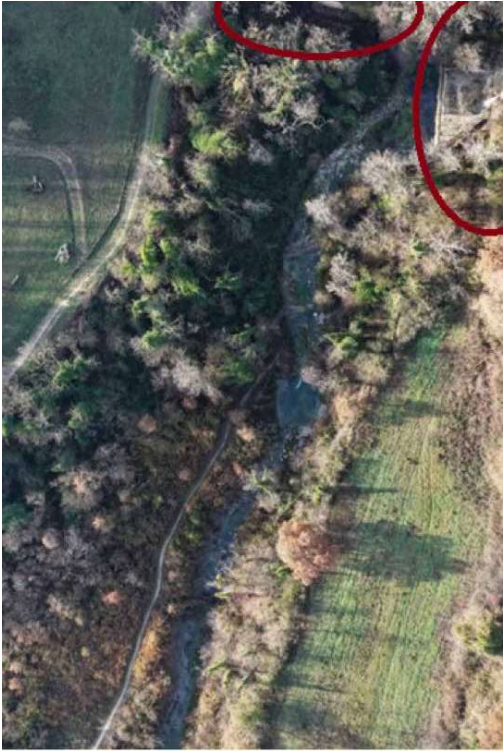
Fig. 17 Zoom dall'alto della foto pre- cedente: detta- glio con il ponte Stucco sul bordo dx della figura e con il dettaglio di un'alta briglia evidenziato sul bordo in basso della figura. A sinistra in basso il campo che si ipotizza destinato a boschetto per sosta e svago.
